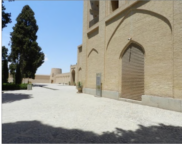
Şekil 5.61 Bagh-e Fin'in Bina ve Çevre Duvarı Tuğla İşçiliği (Dadras, 2021)
