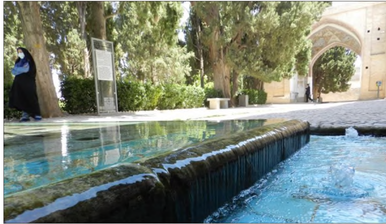
Şekil 5.55 Bagh-e Fin'in Taşma Havuz Savak Detayı (Dadras, 2021)
