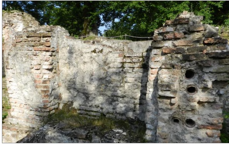
Şekil 5.71 Su Sisteminin Seramik İletim Borular (Tanbusheh) İçin İnşaa Edilen Koruyucu Duvarı ve Boru Görüntüsü (Dadras, 2021)
